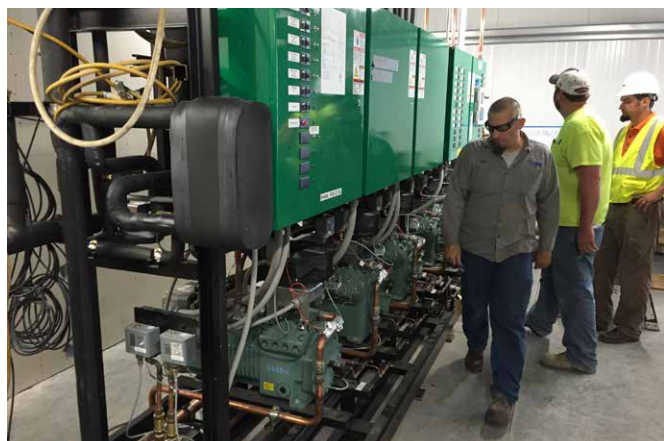
低温冷凍ラックシステムの最終調整をするゼロゾーン、SCR、およびコボーンズ社設備チーム
